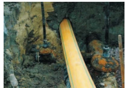
Abb 1-4: Einzug einer egeplast SLM® DCT-Gasleitung durch widrige Bodenverhältnisse
