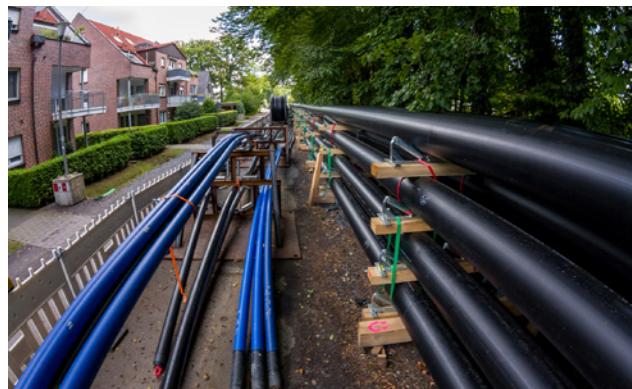
Bild 5: Die Schutzrohre DA 355 wurden zunächst zu längeren Rohrsträngen zusammengeschweißt und bis zur Bündelung mit den anderen Schutzrohren übereinander entlang der Einzugstrasse zwischengelagert
