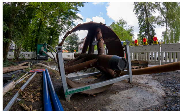
Bild 2: Mit jedem Aufweitbohrkopf wird das Bohrloch bis zum gewünschten Durchmesser vergrößert
