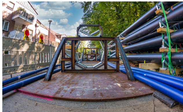
Bild 4: Die Abrollvorrichtungen dienen zur Bündelung der einzelnen Schutzrohre
