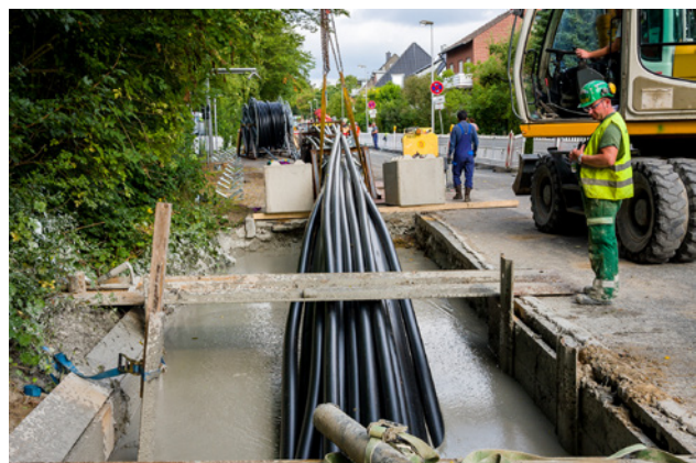
Bild 6: Die einzelnen Schutzrohre werden als komplettes Leitungsbündel in das Bohrloch eingezogen
