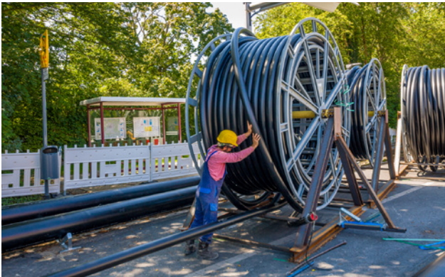
Bild 3: Auf den bis zu 3,20 m durchmessenden Trommeln wurden die kleineren Schutzrohre angeliefert und nach den CAD-Planungen für die Bündelung gelagert
