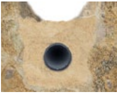
Offene Verlegung im Sandbett Open trench installation in sandbed
