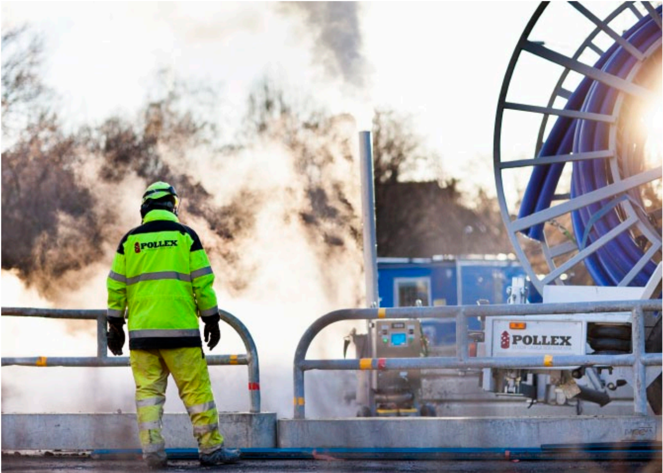
Aufstellen eines egeLiners mit Wasserdampf Resizing of an egeLiner® using hot steam
