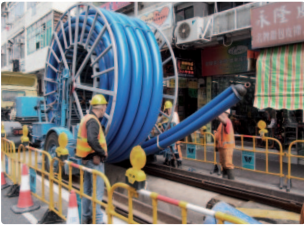
Einsatz des egeLiners bei beengten Platzverhältnissen in Hong Kong Use of an egeLiner® in a difficult spatial situation in Hong Kong
