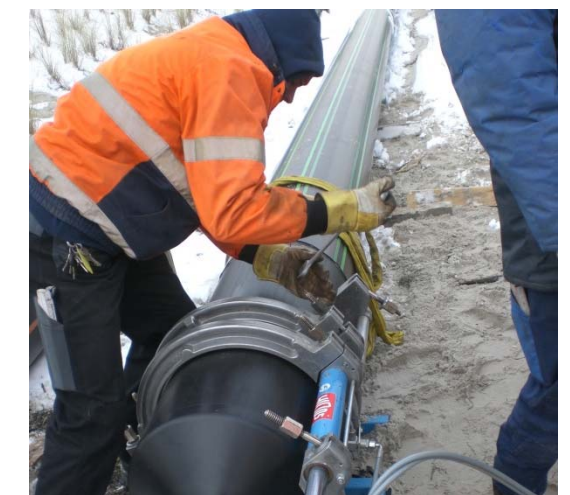
Durch die Düne unter den Strand in die Ostsee: Dank Spülbohrverfahren wurden diese Bereiche bei den Arbeiten nicht belastet.
