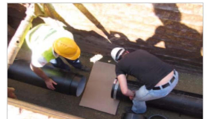
Im Rohrgraben werden Spitzende und Muffenende ausgerichtet
