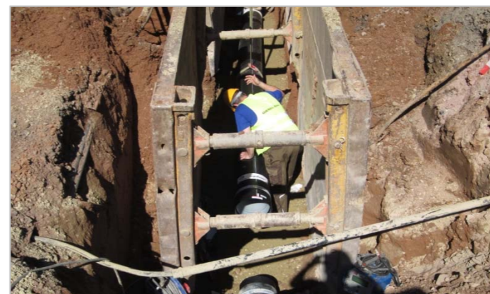
Neuverlegung von Abwasserleitungen System egefuse® mit integrierter Schweißtechnik als Pilotprojekt
