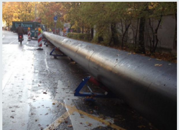
Bild 3: Auf Rollenböcken gelagerter Rohrstrang
