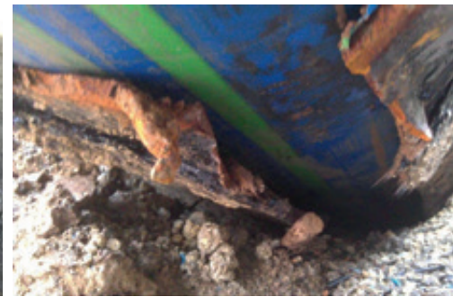
Abb. 4: Einzug eines außenbündig glatten Rohrstangs beim Berstlining
