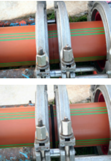
Abb. 5: Heizelementstumpfschweißen von Rohren mit PE-Schutzmantel ohne Mantelrückschnitt
