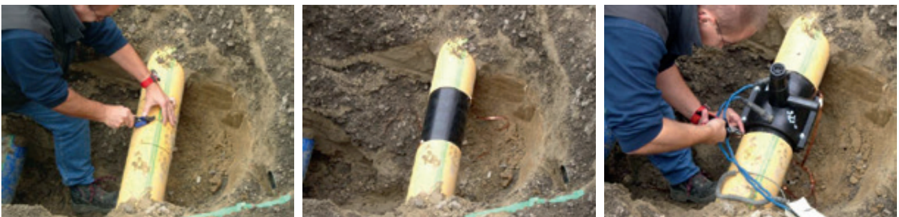
Abb. 3: Entfernen des Schutzmantels eines eingezogenen Schutzmantelrohres und Aufschweißen einer Hausanschlussarmatur
