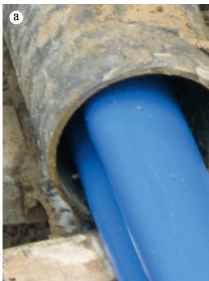
Abb. 4: Der egeplaster gefaltet (a) und geformt (b)
