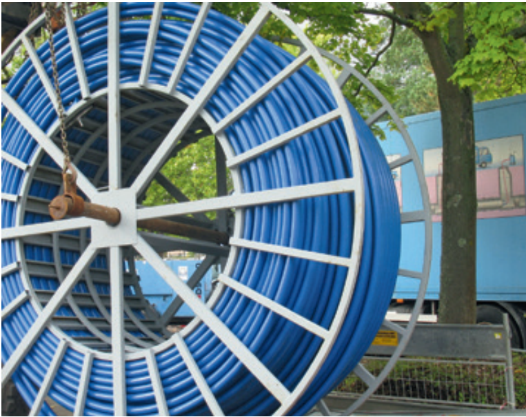
Abb. 3: Der vorgeformte Liner auf eine Trommel gewickelt.
