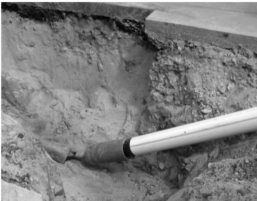
Bild 2. Berstkörper mit angekoppeltem Gelenkstück und der einzuziehenden Leitung aus widerstandsfähigem SLM-Rohr. Foto: Stadtwerke Neuss E + W GmbH.
