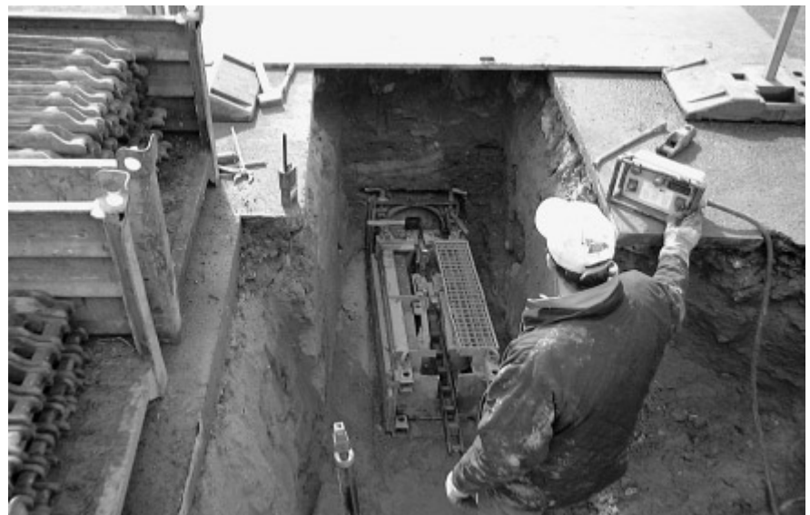
Bild 1. Mit der Lafette wird das Gestänge in die Rohrleitung geschoben. In der Startbaugrube wird anschließend das Rollenmesser mit dem Berstkörper, Gelenkstück und Rohrleitung angekoppelt. Foto: Stadtwerke Neuss E+W GmbH.
