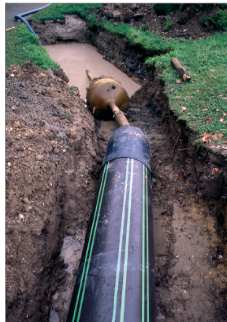
Startgrube der Horizontalspülbohrung
