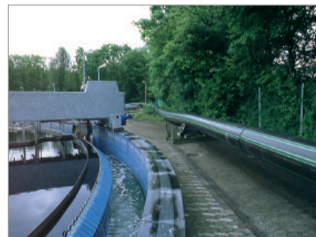
Verschweißte Rohrstränge des egeplast SLM®-Rohres vor dem Einzug. Aus Platzgründen wurde der Rohrstrang von 300 m Länge um das Klärbecken gelegt.
