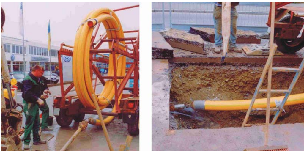
Abbildung 8: Einzug eines Rohrstrangs mit integrierter Beschädigungsüberwachung 3L-SLA ®
