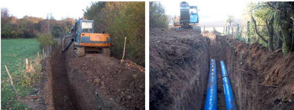
Abbildung 2: Trassenverlauf der Doppelleitung
