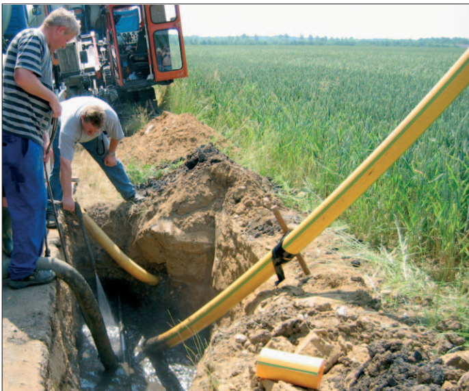
Bild 1: Minimaler Eingriff in die Umgebung durch das horizontale Spülbohrverfahren
