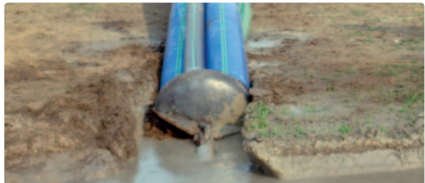
Rohrbündel kurz vor dem Einzug Bundle of drinking water and sewage pipes
