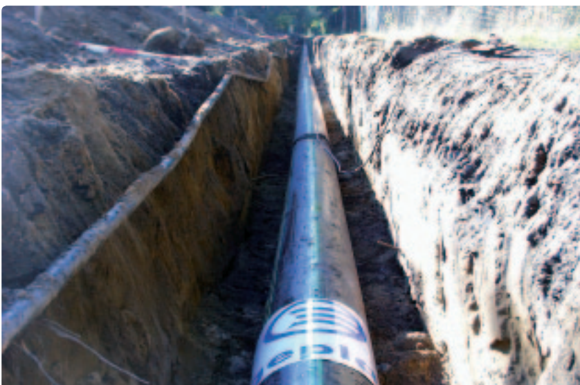
Permeationsdichte Abwasserdruckleitung im Rohrgraben
