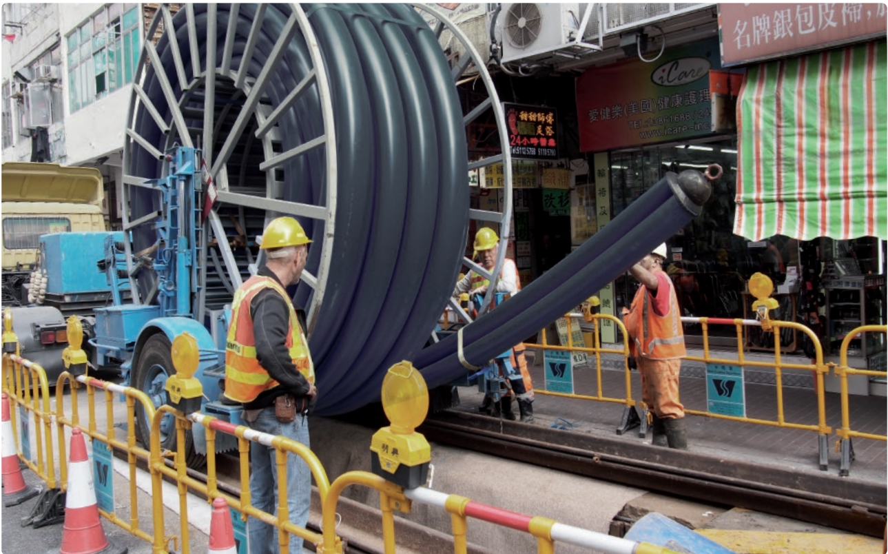
Einsatz des egeLiners bei beengten Platzverhältnissen in Hong Kong Use of an egeLiner® in a difficult spatial situation in Hong Kong
