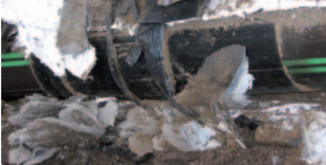
links: Berstlining eines Betonrohres mit einem 3L Sicherheitsrohr; rechts: leck- überwachter Schacht im 3L Sicherheitsrohrsystem left: Pipe bursting of a concrete pipe with a 3L safety pipe; right: Leak moni- tored manhole in the 3L safety pipe system
