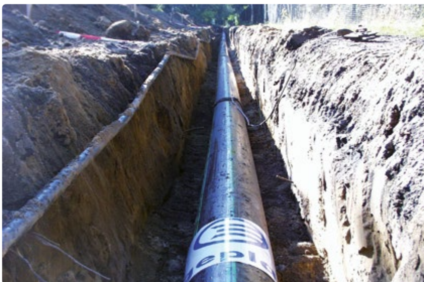
Permeationsdichte Abwasserdruckleitung im Rohrgraben
