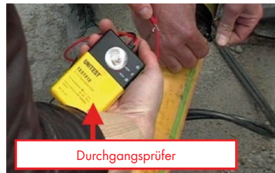
Abb 1-58: Nachweis auf Nichtbeschädigung mittels Durchgangsprüfer
