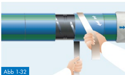
Abb 1-32 Schrumpfbereich der Muffe radial mit Schmirgelleinen aufrauen
