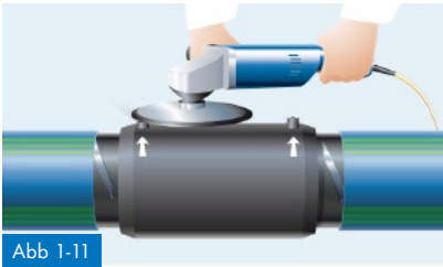
Abb 1-11 Entfernen der Steckkontakte
