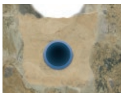
offene Verlegung im Sandbett
