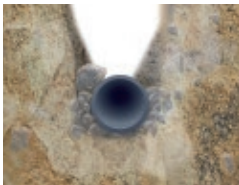
offene Verlegung ohne Sandbett
