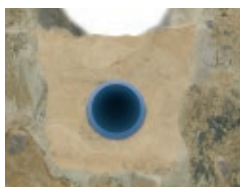
offene Verlegung im Sandbett
