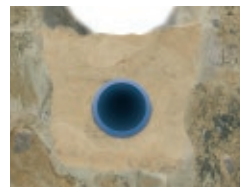
offene Verlegung im Sandbett
