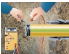
Nachweis auf beschädigungsfreien Einbau nach Verlegung
