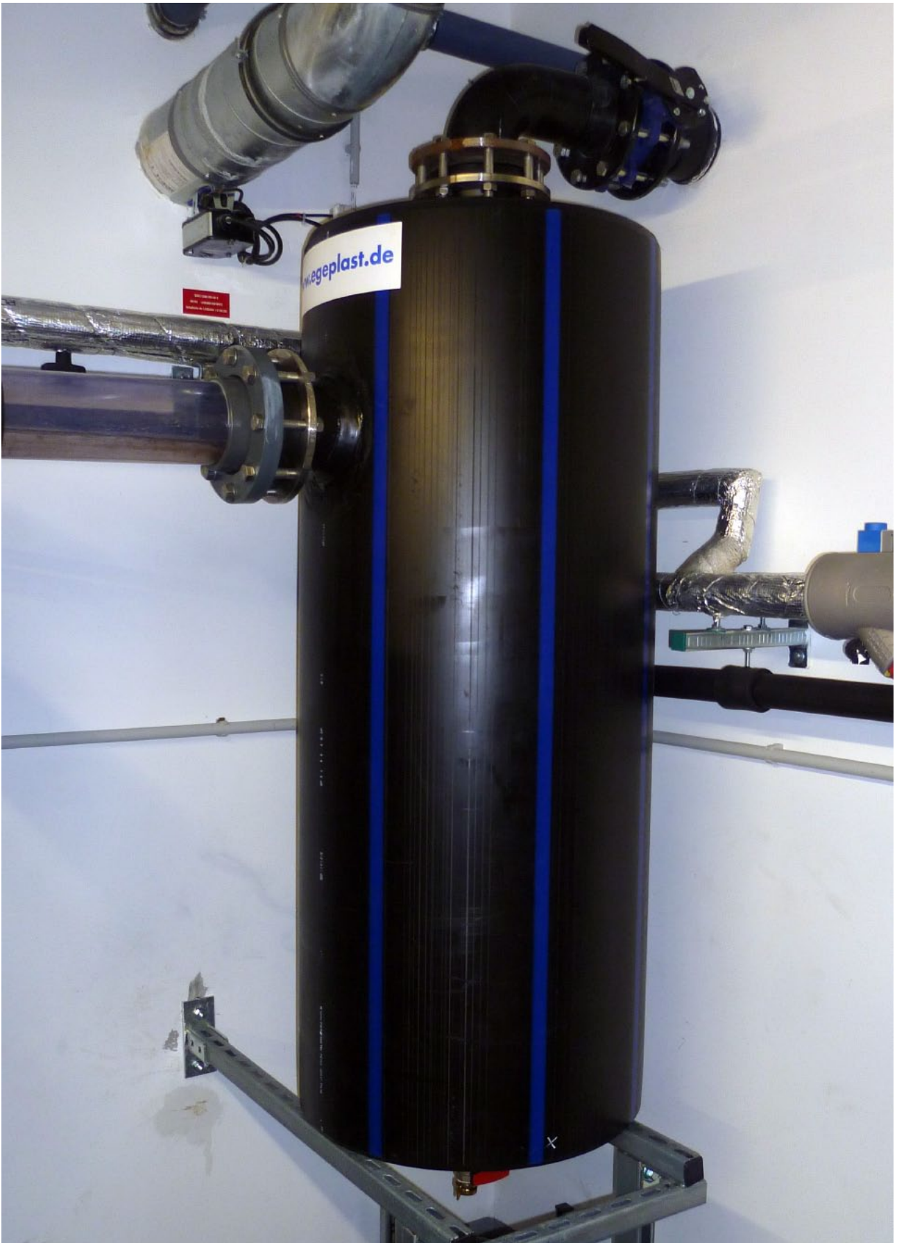
Ausgleichsbehälter OD 710 mm mit Ablass OD 63 mm Compensation tank OD 710 mm with discharge OD 63 mm
