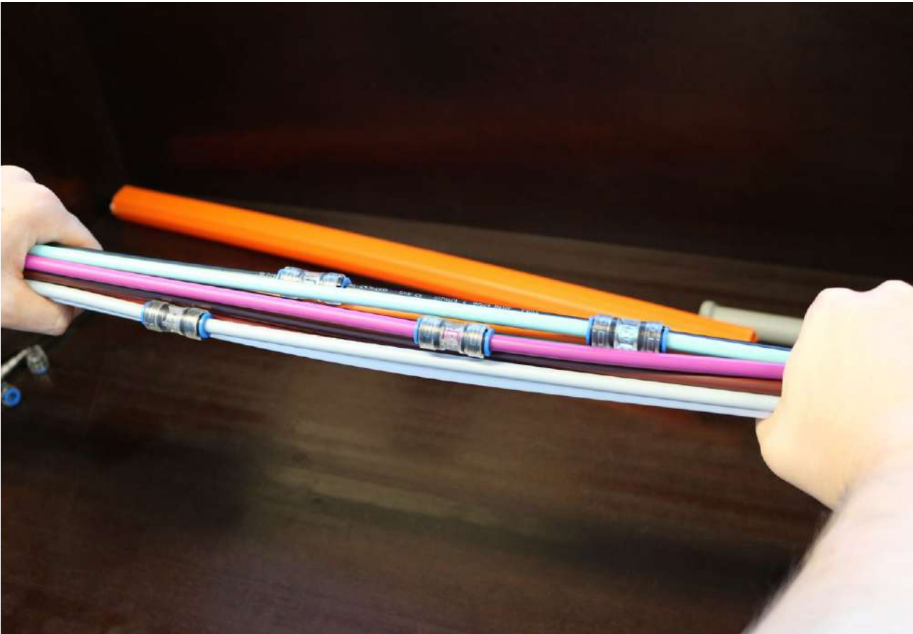
Für das Verbinden zweier Microduct Multi Verbände sollten beide Enden ca. 50 cm überlappen und abgemantelt werden. Hierbei ist zu beachten, dass die Verbinder mit Versatz gesetzt werden, damit keine Biegeradien entstehen.
