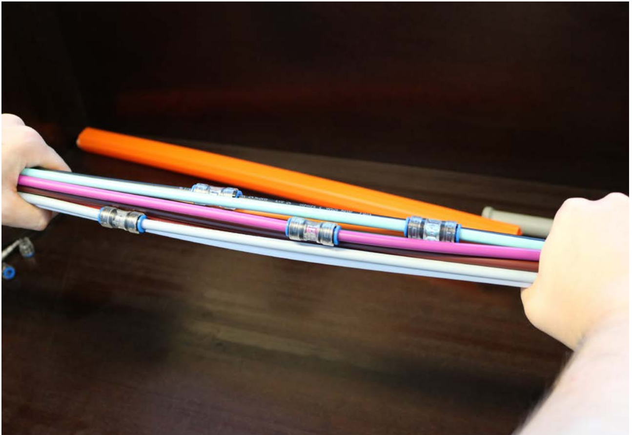
7. Verbinder und Endstopfen bis zum Anschlag aufschieben. Hauseinführungsrohr verbinden.
