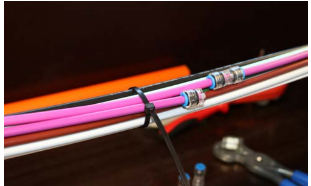
8. Verbindung und Endstopfen mit Kabelbinder oder Ähnlichem fixieren.
