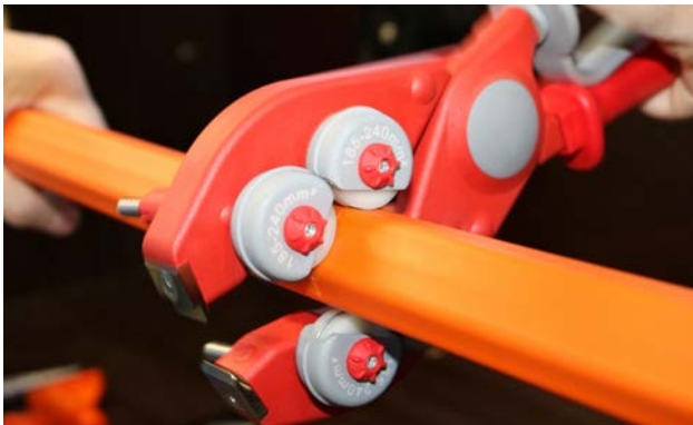
1. Den Mantel mit der Rundschnitzzange an zwei Positionen 60 bis 100 cm entfernt einkerben.
