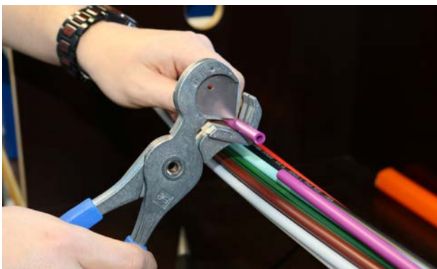
5. Weitere 3 bis 4 cm abschneiden, damit ausreichend Platz für Verbinder und Endstopfen vorhanden ist.
