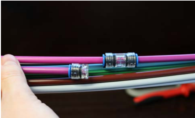
7. Verbinder und Endstopfen bis zum Anschlag aufschieben. Hauseinführungsrohr verbinden.
