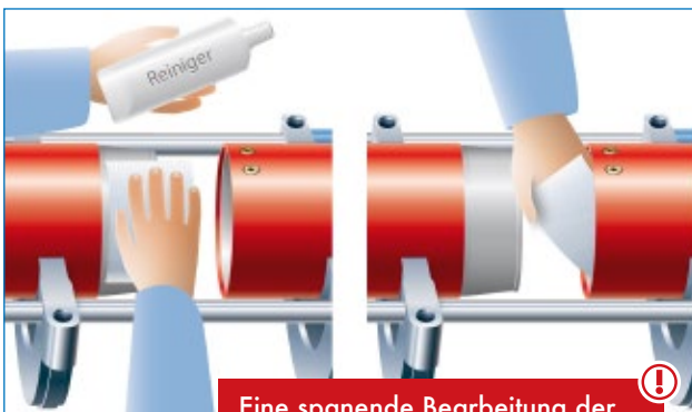
Reinigung der Schweißflächen
