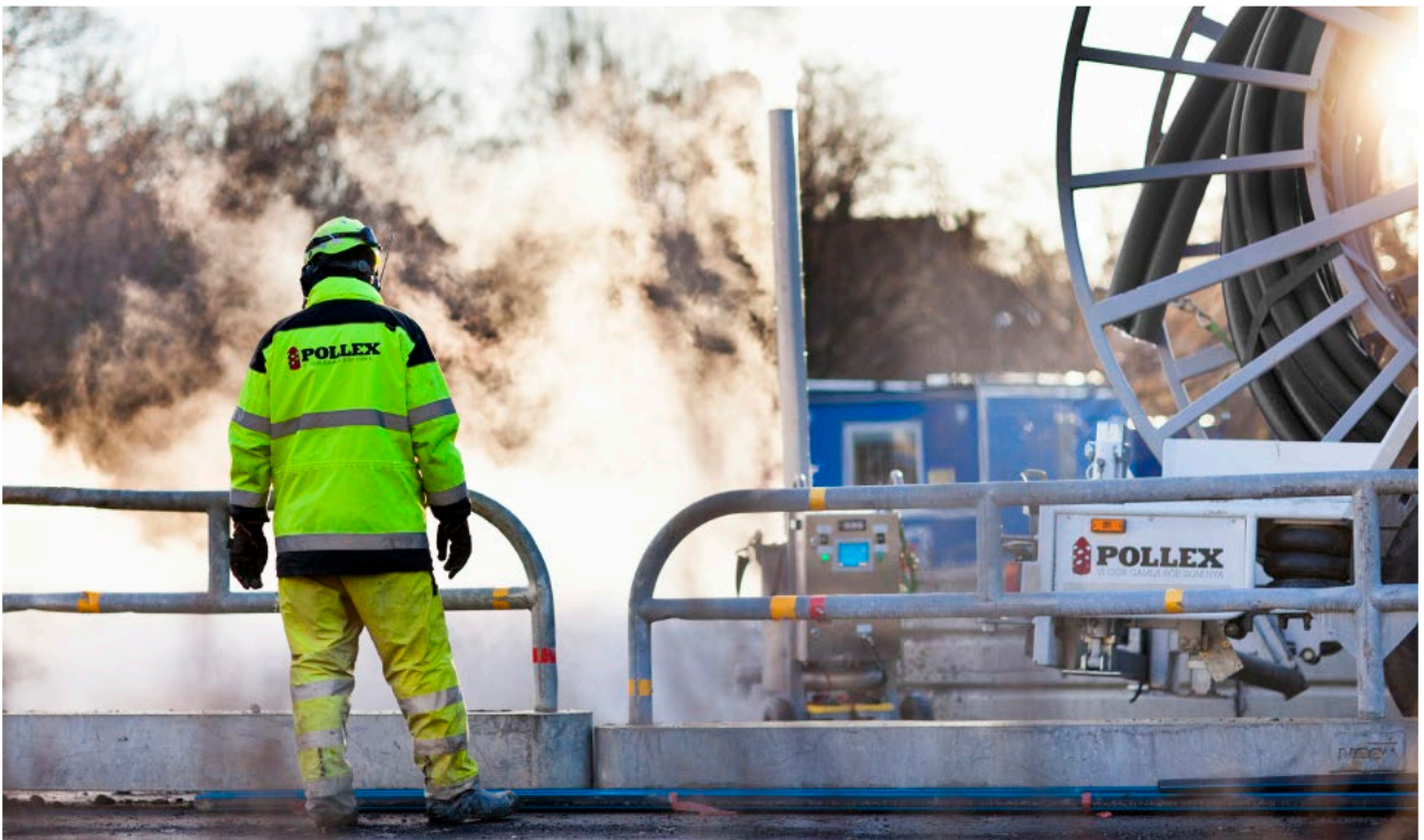
Aufstellen eines egeLiners mit Wasserdampf Resizing of an egeLiner® using hot steam
