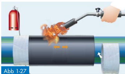
Abb 1-27 Aufschrumpfen der Schrumpfmuffe mittels einer weichen Gasflamme
