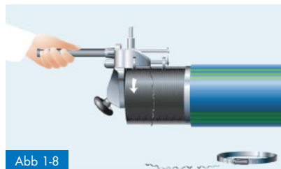
Abb 1-8 Entfernen der Oxidschicht mittels Schälgerät
