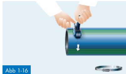
Abb 1-16 Entfernen des Schutzmantels mittels geeignetem Schälgerät
