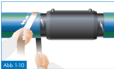
Abb 1-10 Schmiegeln des Schutzmantels im Bereich der Schrumpfmuffen
