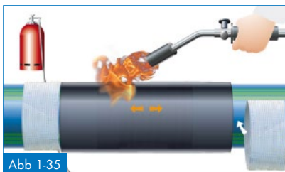
Abb 1-35 Aufschumpfen der Schrumpfmuffe mittels einer weichen Gasflamme
