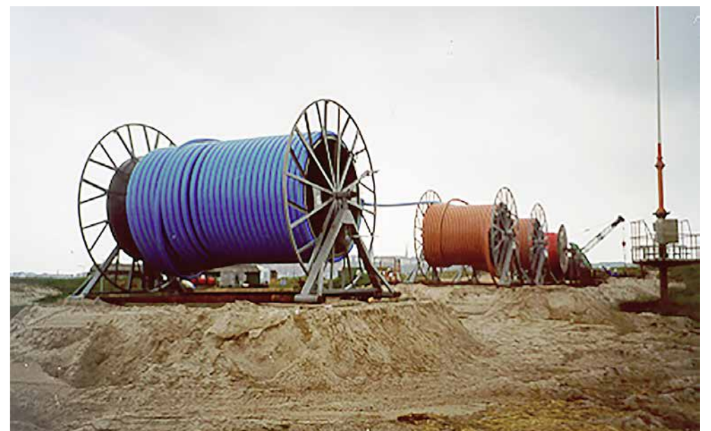
Erneuerung der Trinkwasserversorgung der Düne von Helgoland. Einzug der Dükerleitung mit SLA® Barrier Pipes für Ver- und Entsorgungsleitung unter dem Meeresboden. / Renewal of the drinking water supply network of the dune of Helgoland. Insertion of the culvert pipeline using SLA® Barrier Pipes for the supply and sewage lines beneath the seabed.
