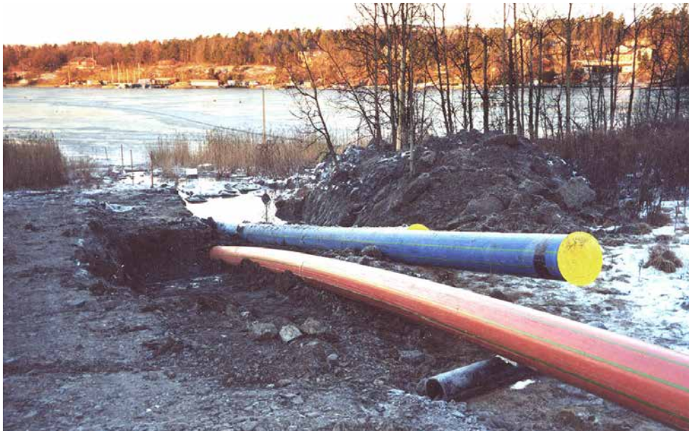
Grabenlose Verlegung von SLA® Barrier Pipes in chemisch belastetem Gewässer nahe Oslo. / Trenchless installation of SLA® Barrier Pipes in a chemically contaminated water body near Oslo.
