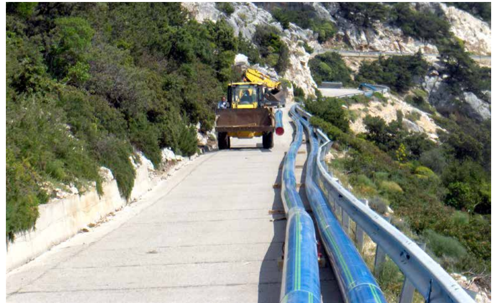
Neue Trinkwasserleitung mit SLA® Barrier Pipes in Sardinien, der Einzug erfolgte im Spülbohrverfahren. / New drinking water pipe with SLA® Barrier Pipes in Sardinia. The pipes were inserted by means of horizontal directional drilling.
