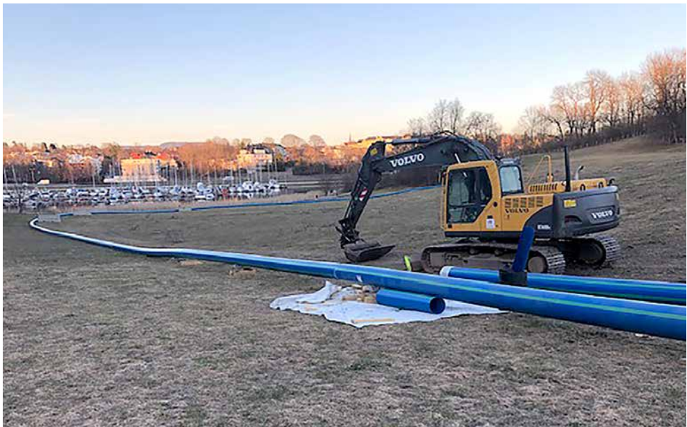
Neue Trinkwasseranbindung der Inseln Bygdøy und Hovedøya im Oslo Fjord. Dabei setzt die Oslo Kommune auf SLA® Barrier Pipes. / New linkage of the islands of Bygdøy and Hovedøya in the Oslo fjord to the drinking water supply network. For this project, the city of Oslo decided to use SLA® Barrier Pipes.
