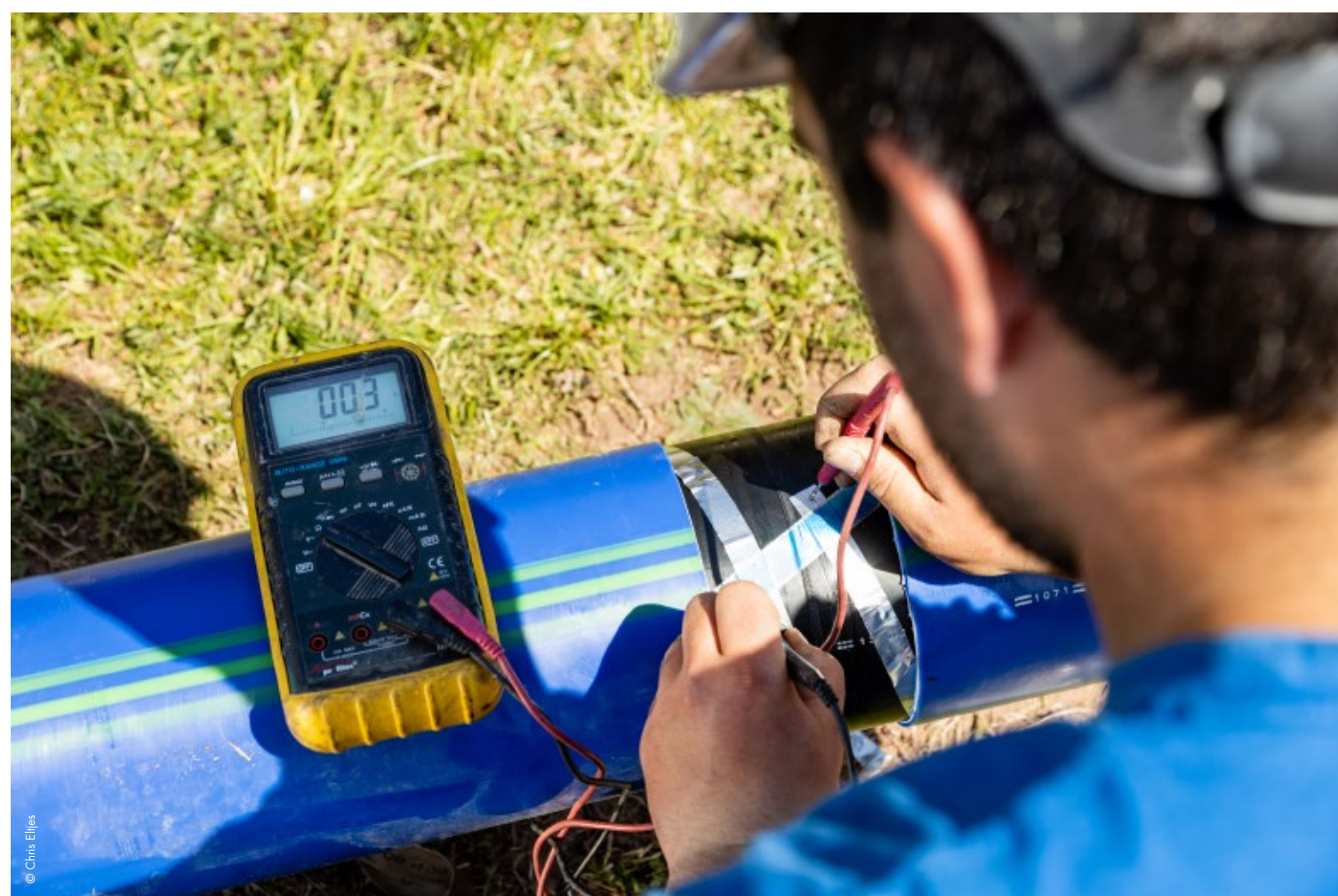
Nach der Verschweißung erfolgt die Herstellung der elektrischen Verbindung und das Messen des ohmschen Widerstandes. / The measurement of the ohmic resistance and preparation of the electrically conductive bridge is carried out after welding.
