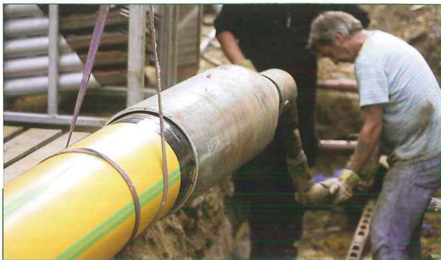
Bild 1: Vorbereitung des Rohrstranges zum Einzug in die Berststrecke
