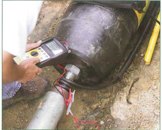
Bild 3: Kontrolle des Isolationswiderstandes des mitgeführten Kabels nach der grabenlosen Verlegung
