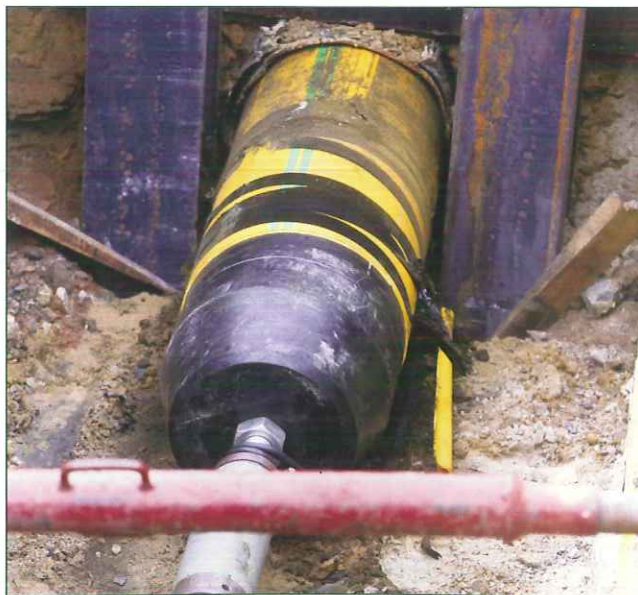
Bild 2: Beginn des Aufweitvorgangs; gut sichtbar: das unter dem Schutzmantel mitgeführte Kabel-Leerrohr
