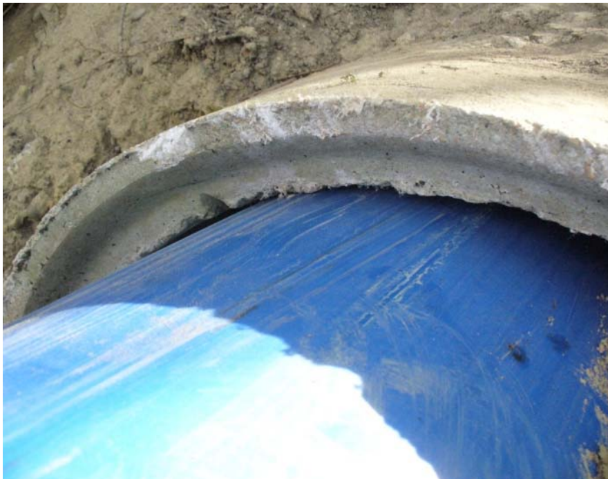
Bild 1: Schwächung der Wanddicke durch Riefen beim Rohreinzug
