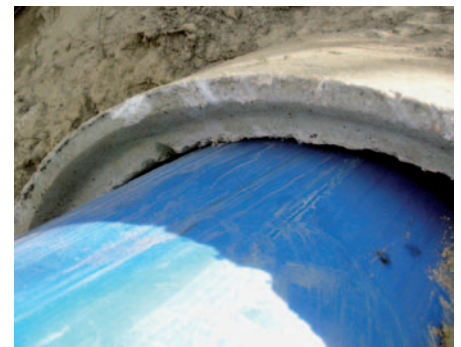
Bild 1: Alternative Verlegetechniken stellen höchste Anforderungen an die verwendeten Rohre
